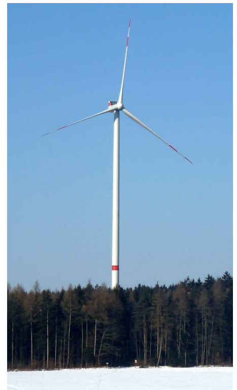
Blick auf das neue Kastler Windrad
